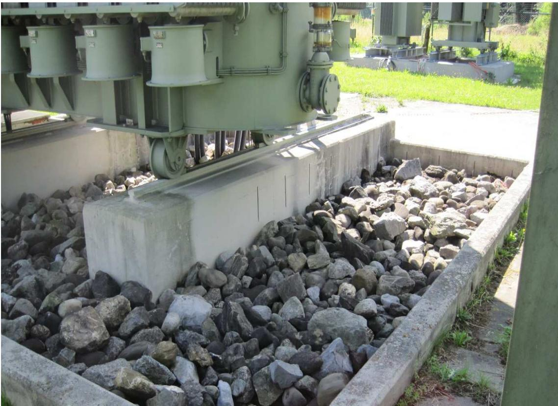
Abbildung 3: Schottergefüllte Transformertrench
