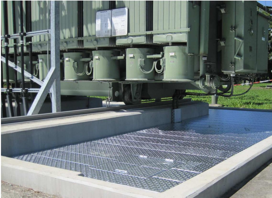
Abbildung 5: Grubenabdeckung mit Revisionsklappe
