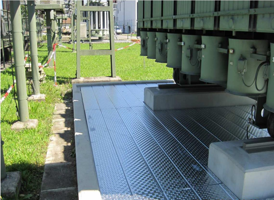
Abbildung 4: Abdeckung mit Blechprofilrosten
